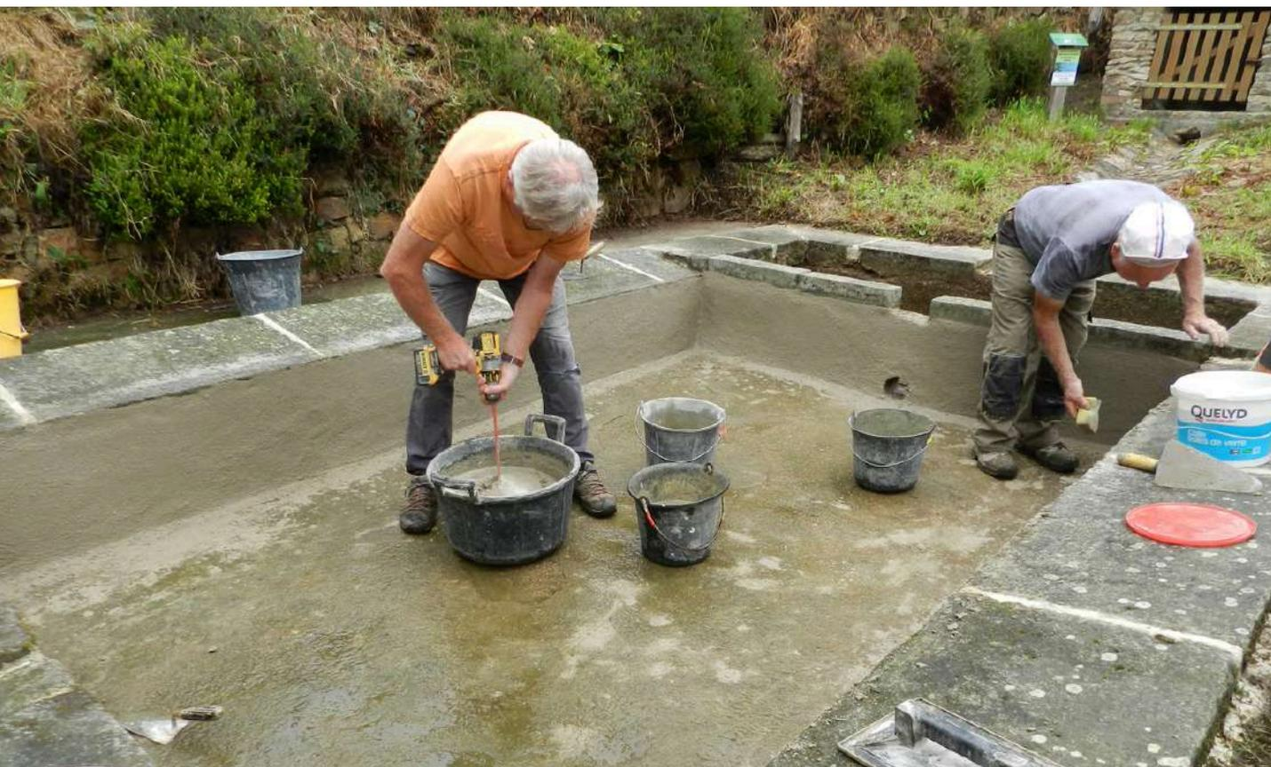
*Recours à un mortier sable - ciment à l'intérieur du lavoir © Lavoires et Fontaines à Plaintel*
