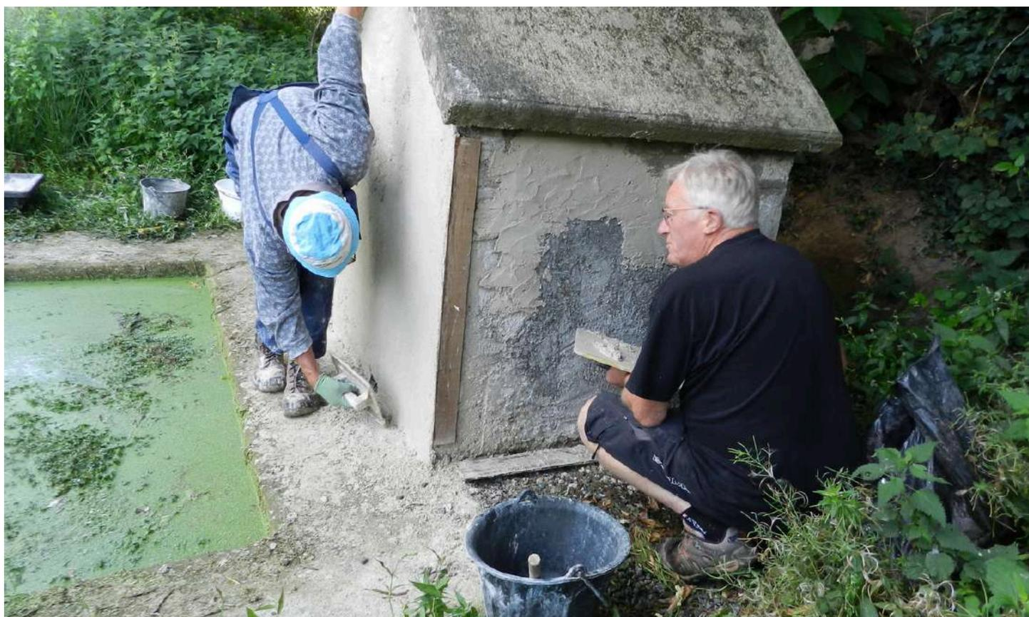
*Recours à un mortier sable - chaux à l'extérieur du lavoir © Lavoires et Fontaines à Plaintel*
