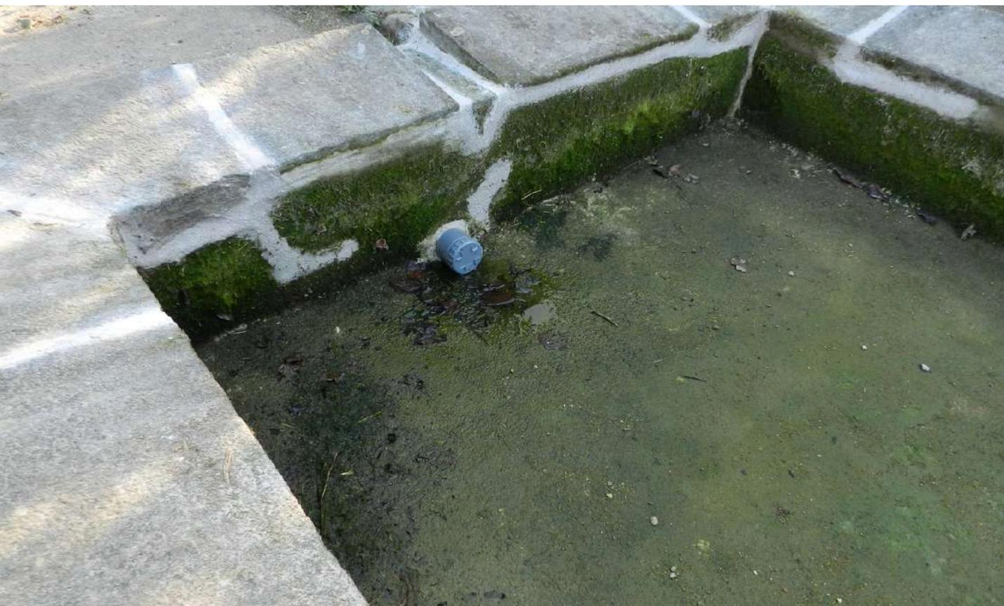
*Pose d'une bonde de vidange munie d'une tête vissée © Lavoires et Fontaines à Plainel*
